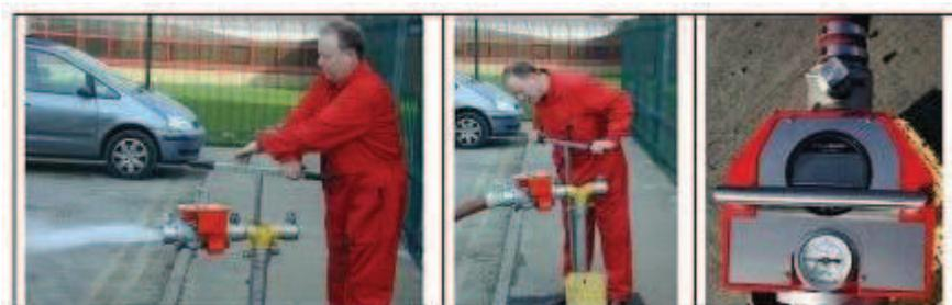
Abb. 3.1: Überprüfung eines Unterflurhydranten mit einem Standrohr. Beispiel für Durchflussmessung und Ablesen des Restdrucks. Fotos mit freundlicher Genehmigung von Essex County Fire and Rescue Service und Laois Fire Service.
