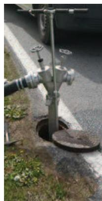
Abb. 4.2: Überflurhydrant und Standrohr am Unterflurhydranten
