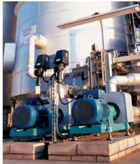
Stabförmige Zweistiftsockel-Leuchstofflampen-Leuchten in der Schutzart Ex-e zur Ausleuchtung einer Pumpstation. Ex-e Drehstrom-Käfigläufer-Motoren als Pumpenantriebe mit steckbar ausgeführten Anschlüssen (Ex-d/Ex-e).
