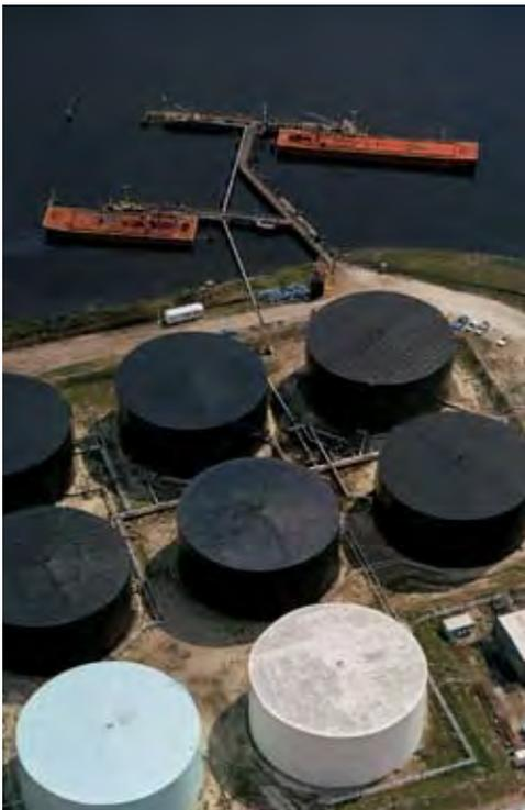
Anwendungsbeispiel für Zone 0: Das Innere der Flachbodentanks eines Öl-Terminals
